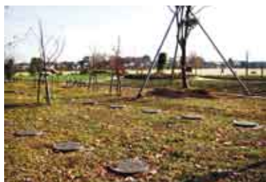
非常用トイレ群 囲いをして簡易トイレ
