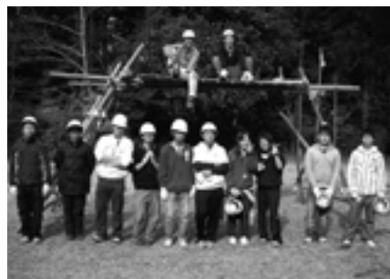
19CVFパイオニアリング橋脚完成
